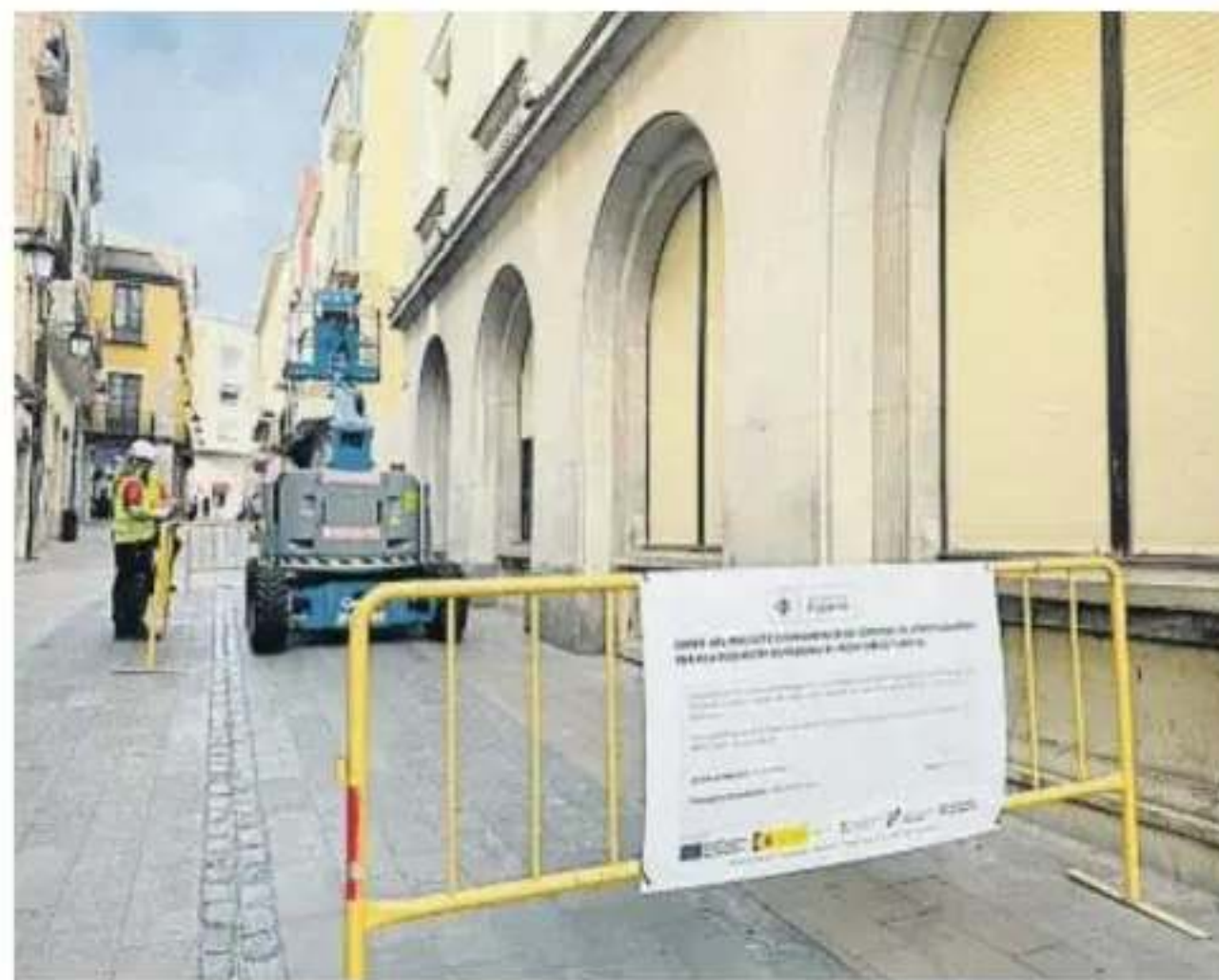
Los trabajos de colocación de los dispositivos empezaron ayer
